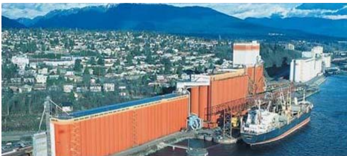
Figure 49: Vue aérienne des installations terminales appartenant à James Richardson International Limited (à gauche) et à la Saskatchewan Wheat Pool, Inc. (à droite) à North Vancouver, Colombie-Britannique.
